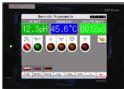
Einstellung und Überwachung der Badparameter vom Touchscreen-Bedienterminal (PRS-Steuerung)
