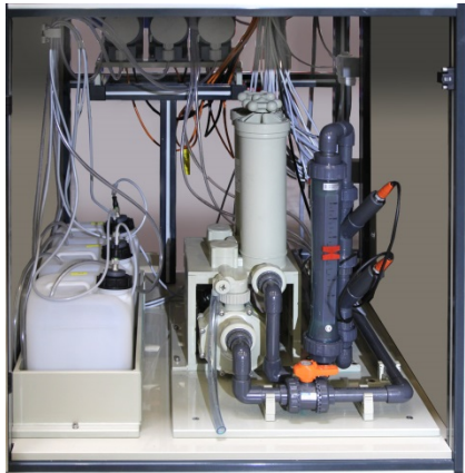
Innenansicht der PRS mit Vorratsbehältern für Elektrolytkonstanthaltung und pH-Regulierung, Dosierpumpen, Umwälzpumpe M50, Kerzenfiltereinheit 2 x 10", Durchflussmesser und Durchflussmengventil
